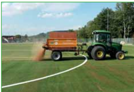
Nachstreuen von Füllstoffen (Quarzsand, Kork, sämtliche Granulate)
