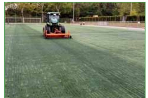
Dekompaktieren von verdichteten Belagsflächen
